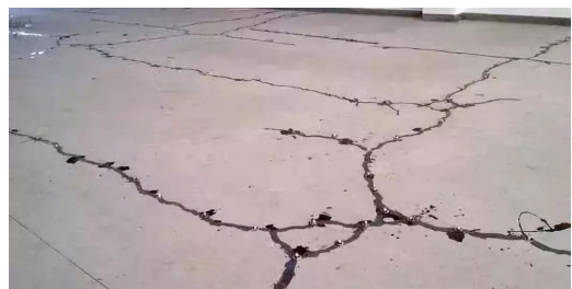
图2 混凝土裂缝
